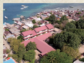
バランロンボ島にあるハサヌディン大学のMarine Station (写真の赤い屋根の建物)の敷地内にパイロット事業の設備が設置される。
